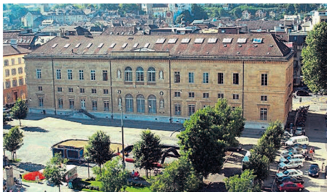
Le Collège latin présente de très bonnes performances environnementales avec un indice de dépense d'énergie primaire (chauffage et électricité) de 117 kWh/m 2 an. L'inertie de ses murs de 80 centimètres d'épaisseur explique ce phénomène.
